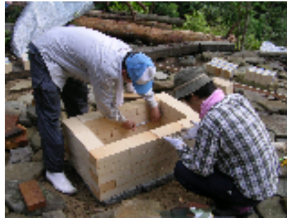
図3、とりあえず耐火煉瓦を積んでみる。
