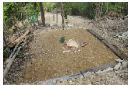
図7、バーベキューの炉を製作中
