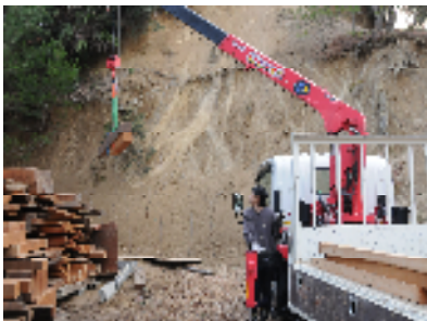
図 3、建設資材をクレーン車で運ぶ。
