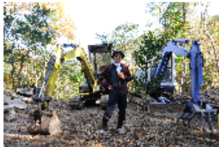
図 5、ユンボ 2 台で山の斜面を整地する。
