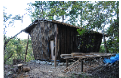
図 8、茶室？を建設。(平成 22 年 8 月 20 日)
